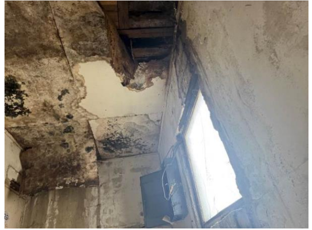
Նկ. 6 Տանիքից ներթափանցած մթնոլորտային տեղումների ջրերի ազդեցությունից առաջացած վնասվածքների տեսքերը
