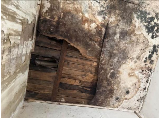
Նկ. 6 Տանիքից ներթափանցած մթնոլորտային տեղումների ջրերի ազդեցությունից առաջացած վնասվածքների տեսքերը
