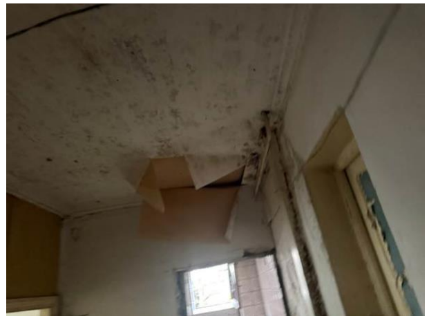
Նկ. 4 Տանիքից ներթափանցած մթնոլորտային տեղումների ջրերի ազդեցությունից առաջացած վնասվածքների տեսքերը
