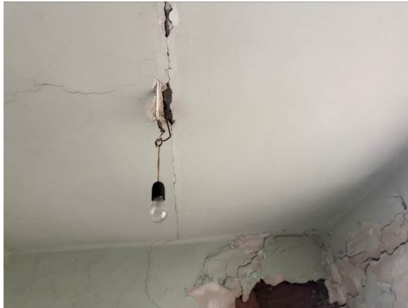
Նկ. 7 Տանիքից ներթափանցած մթնոլորտային տեղումների ջրերի ազդեցությունից առաջացած վնասվածքների տեսքերը
