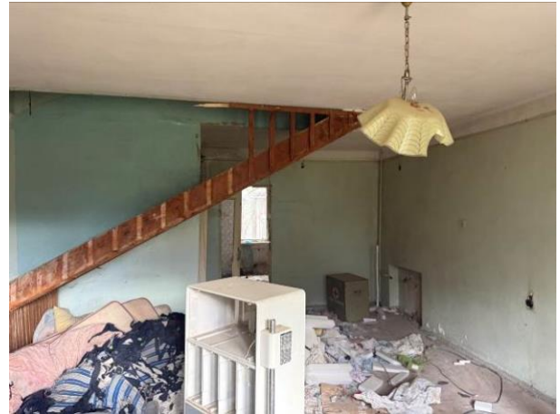
Նկ. 9 Հատակների, դռների ու պատուհանների և ներքին հարդարման վնասվածքների տեսքերը
