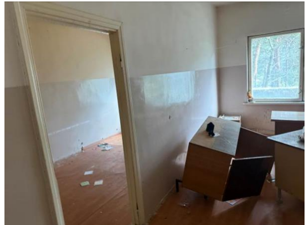
Նկ. 6 Դռների, պատուհանների, հատակների և ներքին հարդարման վնասվածքների տեսքերը
