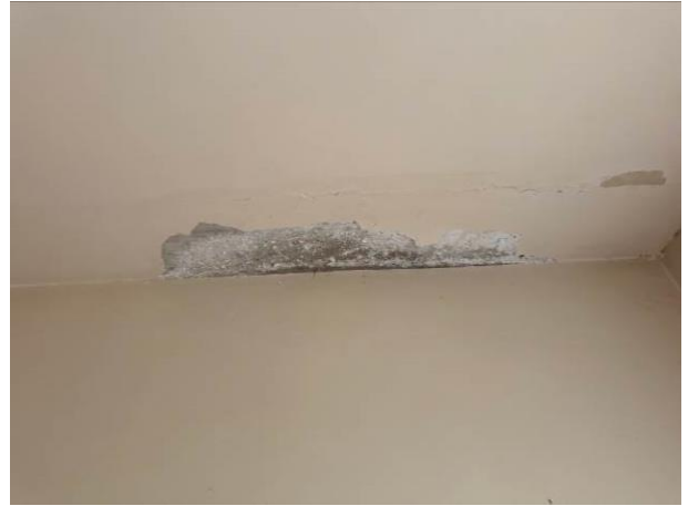
Նկ. 3 Տանիքից ներթափանցած մթնոլորտային տեղումների ջրերի ազդեցությունից առաջացած վնասվածքների տեսքերը
