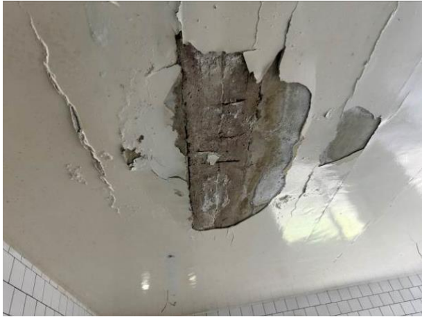
Նկ. 3 Տանիքից ներթափանցած մթնոլորտային տեղումների ջրերի ազդեցությունից առաջացած վնասվածքների տեսքերը
