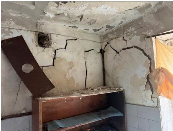
Նկ. 4 Տանիքից ներթափանցած մթնոլորտային տեղումների ջրերի ազդեցությունից առաջացած վնասվածքների տեսքերը
