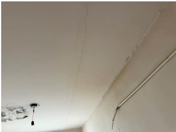
Նկ. 4 Ծածկի հարակից սալերի միջև կարանների լցափակումների թերությունների հետևանքով կարանների սվաղում առաջացած ճաքերի տեսքերը
