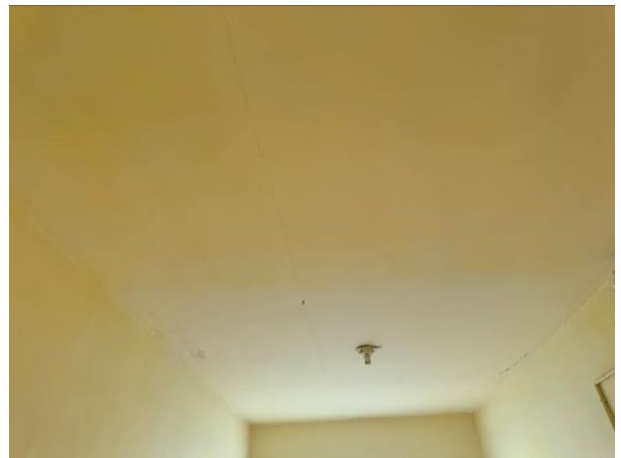
Նկ. 4 Ծածկի հարակից սալերի միջև կարանների լցափակումների թերությունների հետևանքով կարանների սվաղում առաջացած ճաքերի տեսքերը
